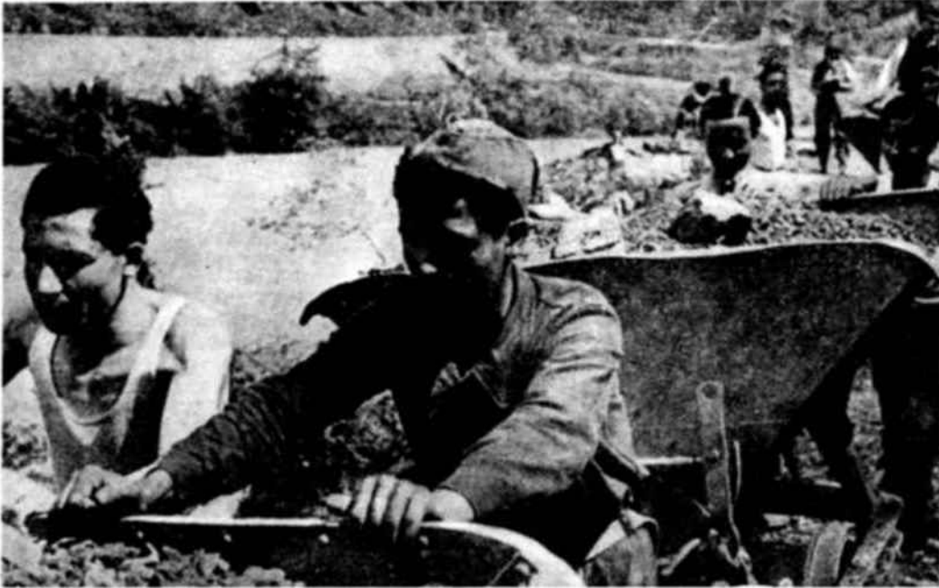
Reparando un ferrocarril
