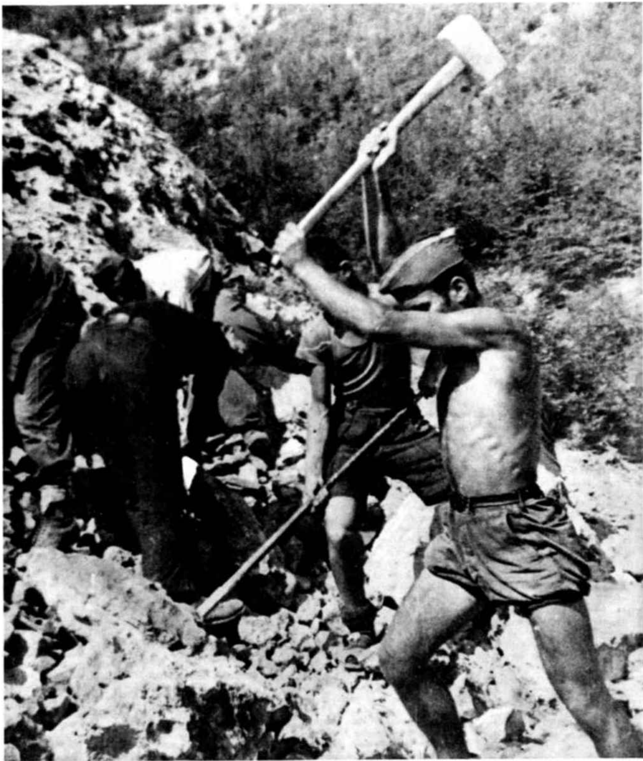
Trabajando en un campo de Voluntarios
