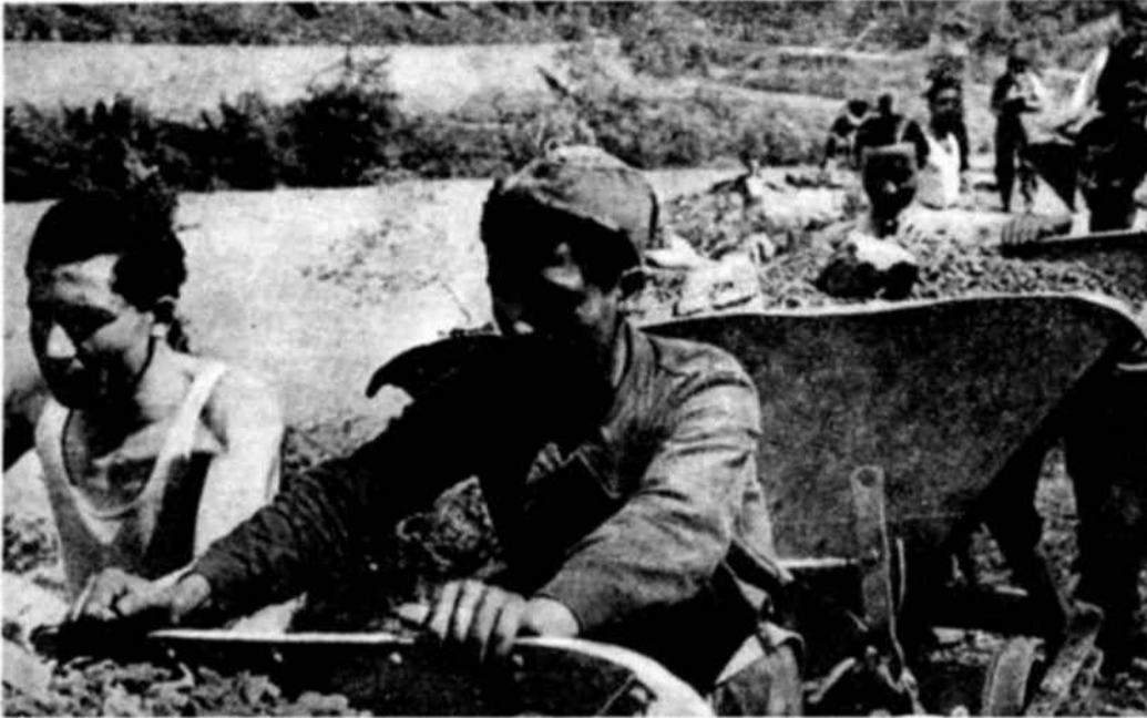
Reparando un ferrocarril
