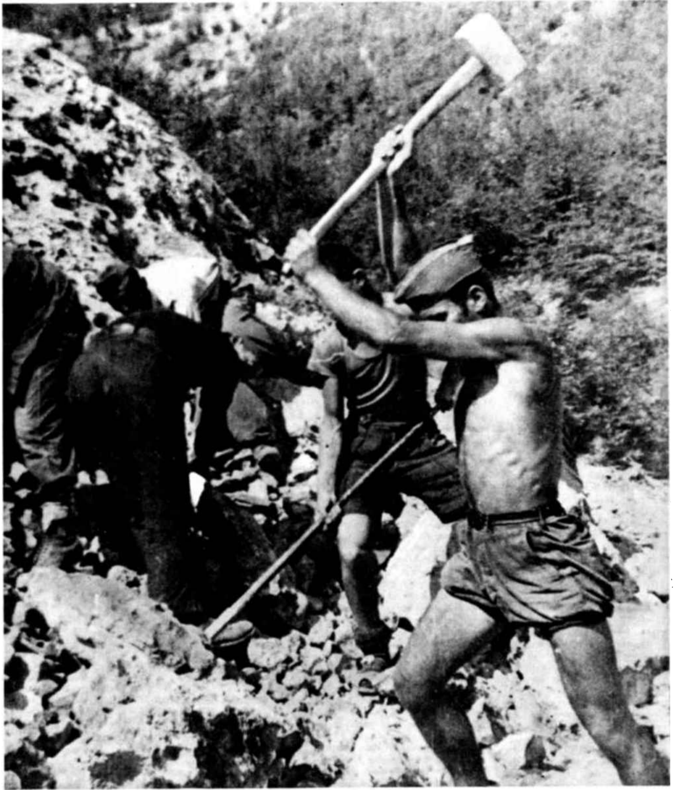
Trabajando en un campo de Voluntarios
