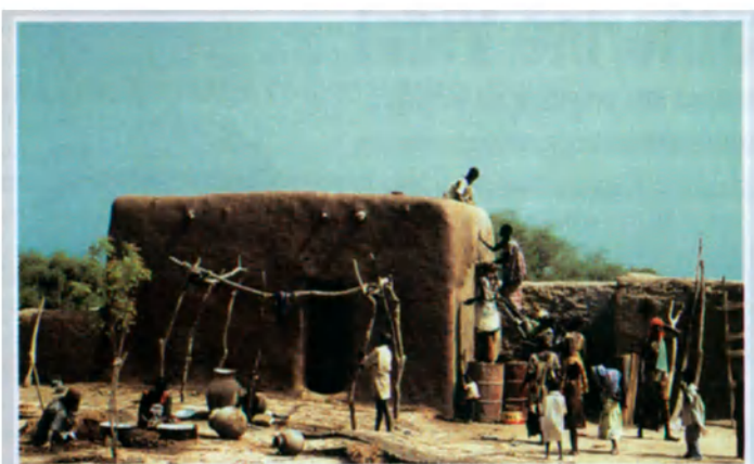
En una aldea kotoko, en el norte del Camerún, mujeres constructoras reparan una casa de adobe y enseñan su arte a las nuevas generaciones.
