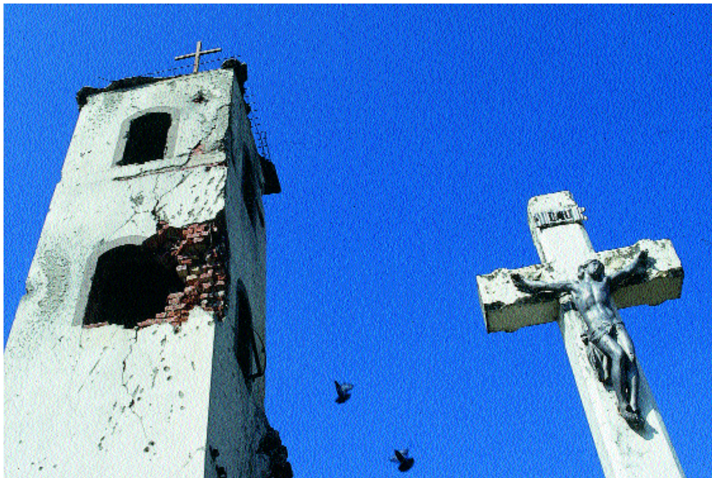
Una iglesia en Croacia destruida cuando se combatía en Lipik.
