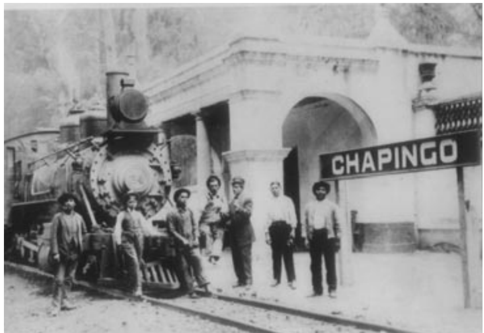
Tripulación junto a la locomotora de vapor en la estación de Chapingo
