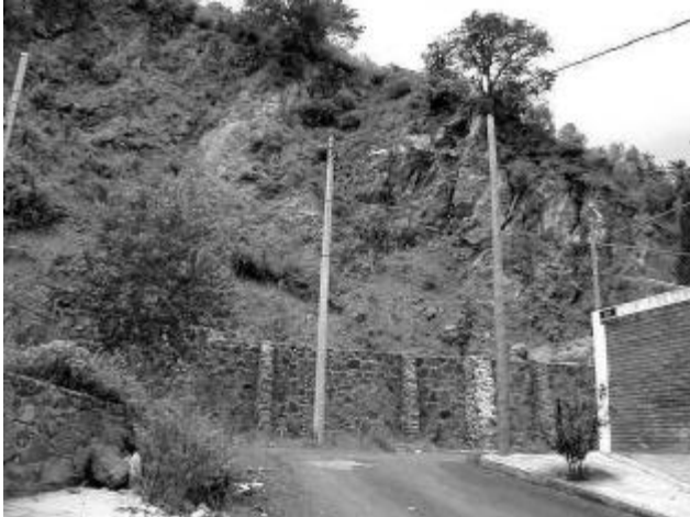
Figura 11. Fotografía de un banco abandonado, en el cual se pueden observar las dimensiones de los bloques, así como las discontinuidades presentes en este macizo rocoso.
